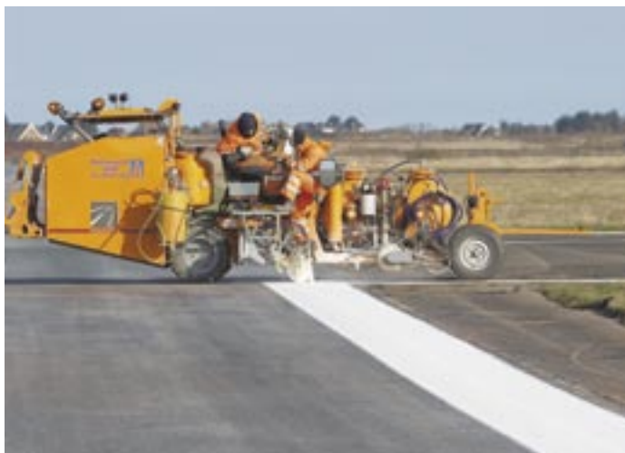
Markierung NF renouvelle le marquage de l'aéroport de Sylt à l'aide d'une BM C 350-2A équipée d'un bras airport marker.
