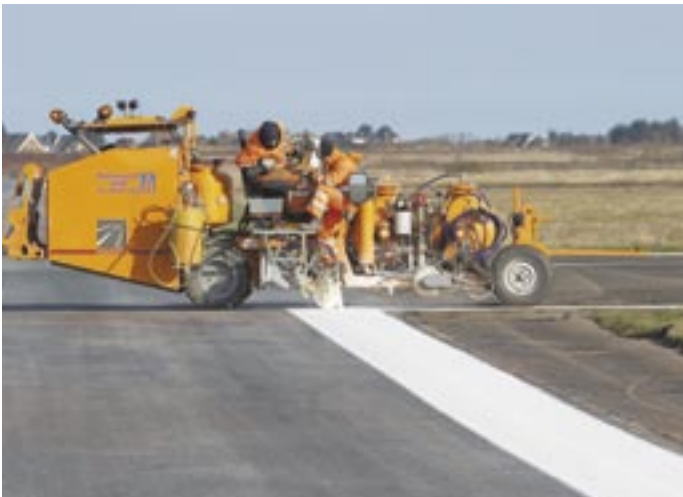
Markierung NF erneuert die Flughafenmarkierungen auf Sylt mit einer mit Airport Marker ausgerüsteten BM C 350-2A.
