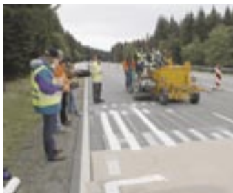
Nouveauté mondiale Borum lors d'un essai de marquage organisé par l'union routière allemande sur l'autoroute B4 à Harzen en Allemagne. Borum est fière du résultat optimal et de loin supérieur au niveau généralement reconnu comme « pratique d'excellence ».
