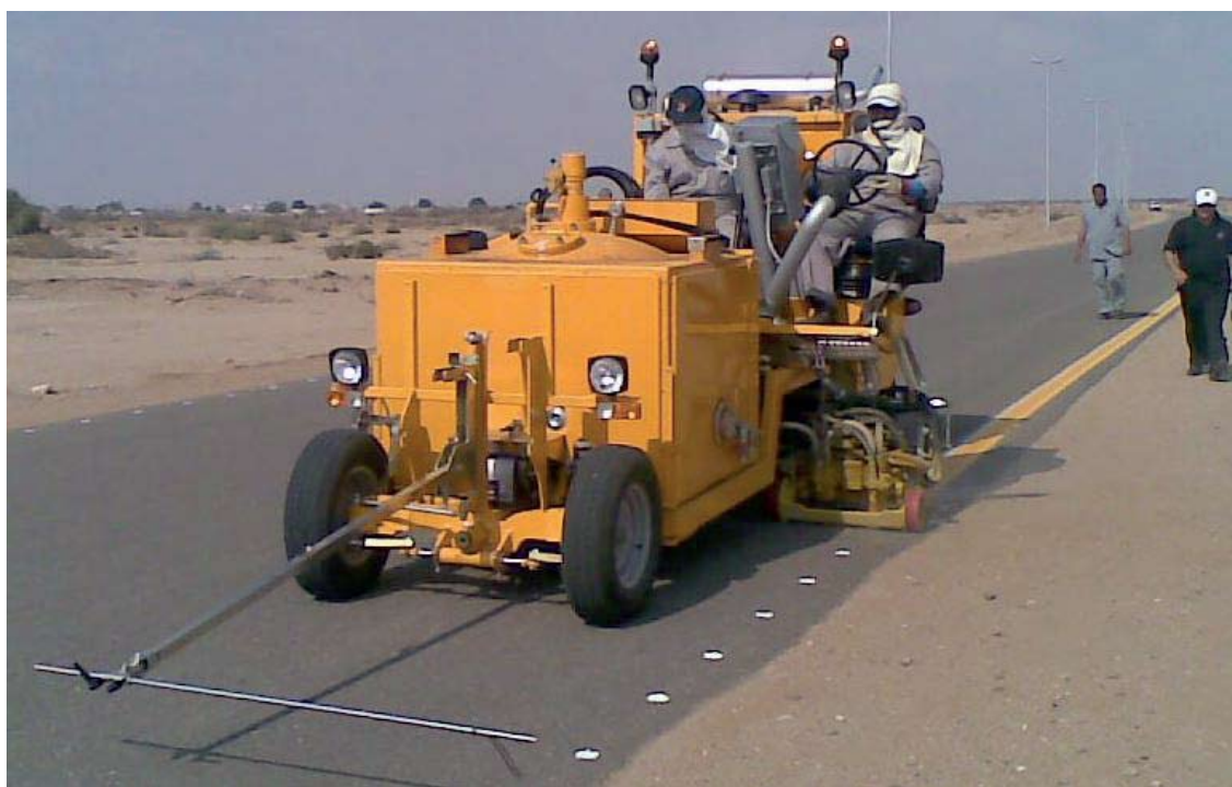
Après une courte formation en compagnie de l'équipe Borum, Al Owaidah vient de terminer un très beau projet de marquage au sol à Jizan, à proximité de la frontière qui sépare l'Arabie saoudite et le Yémen.
